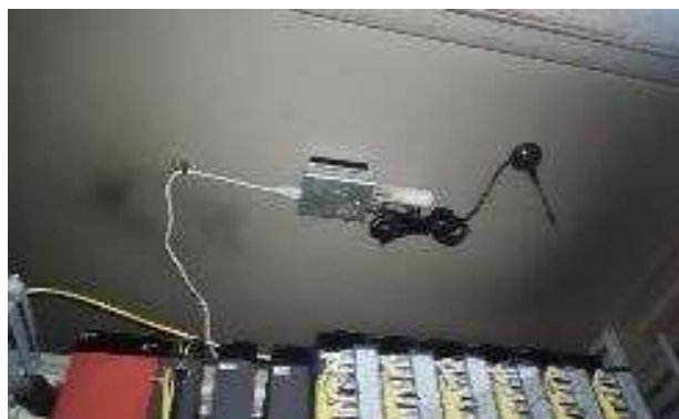
図 2-8 PLC の温度監視システムの例
